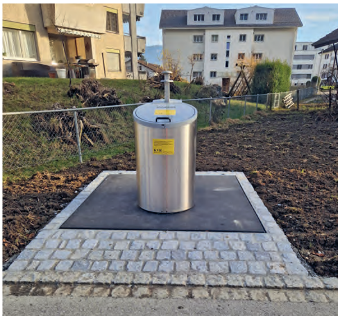
Neu erstelltes Unterflursystem an der Neudorfstrasse
