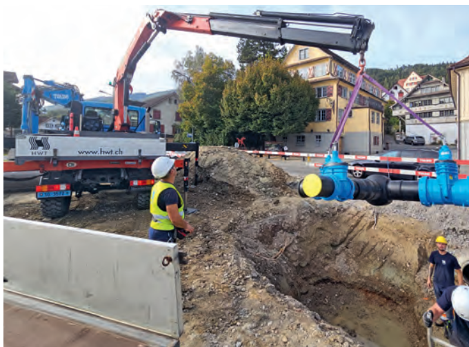
Der Innendurchmesser des Verteilkreuzes wurde von 125 mm auf neu 250 mm erhöht.
