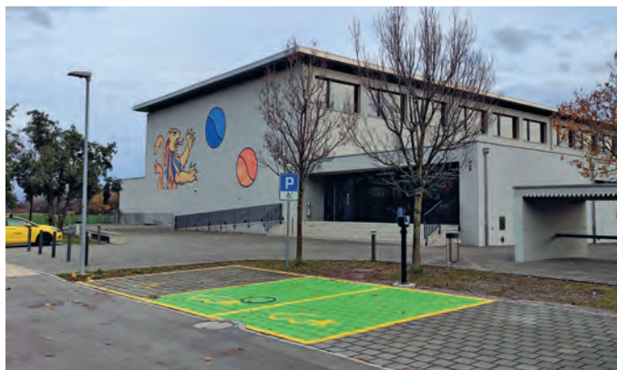
Neue Ladestationen für Elektrofahrzeuge beim Hallenbad Balgach
