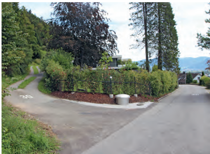
Im 2023 wurden die Quellen Kleinenberg saniert.
