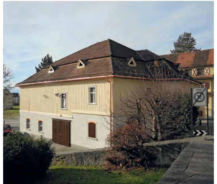
Rösslistadel nach Sanierung
