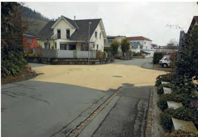
Strassenmarkierung Kreuzung Eichholz-/Dachertstrasse
