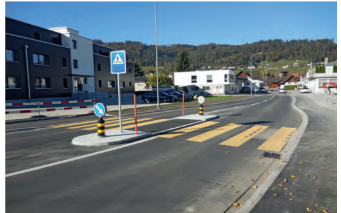
Neue Fussgängerüberquerung Rietstrasse
